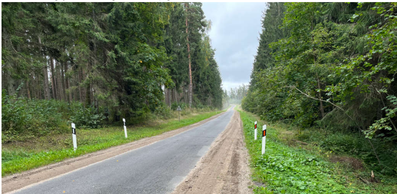
3 pav. Rekonstruojamas kelias Nr. 179
